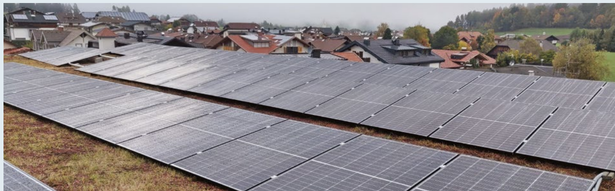
Projekt Energie: auf den öffentlichen Gebäuden wurden Solaranlagen angebracht.
