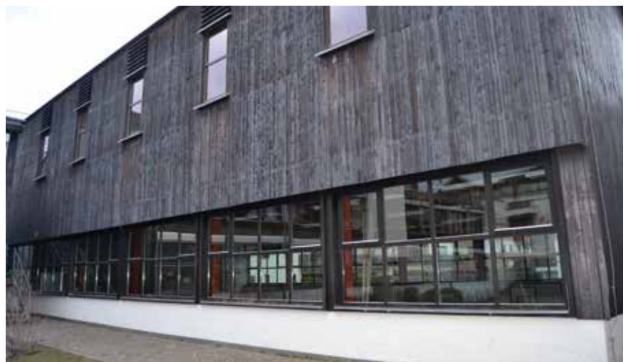
Umbau und Sanierung der Turnhalle in Mitterlang soll mehr als zwei Millionen Euro kosten.
