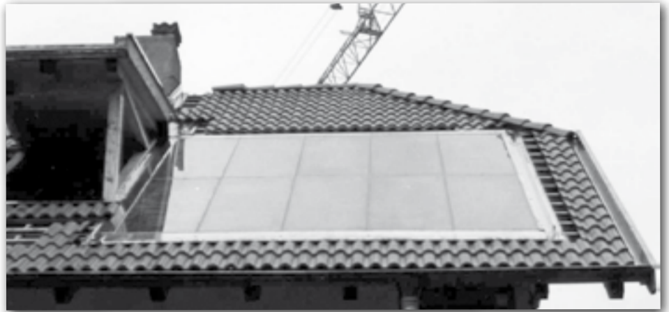
) Auch für den Einbau von Sonnenkollektoren gibt es finanzielle Anreize.
