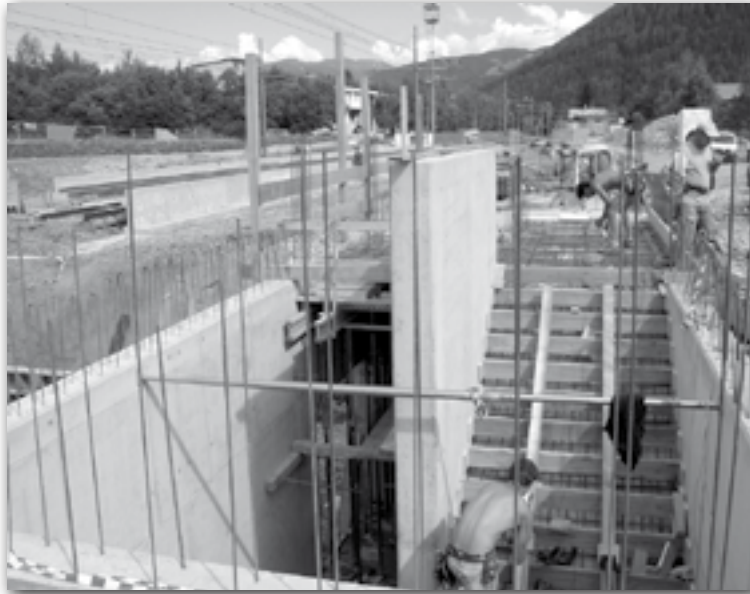
Die Bauarbeiten für den neuen Bahnhof laufen wegen der Schließung des Zugverkehrs auf der Pustertaler Linie auf Hochtouren; Martin Vieiders Forderung nach einer Baueinstellung fand im Gemeinderat keine Mehrheit. (Foto: „SQ“/rb)
