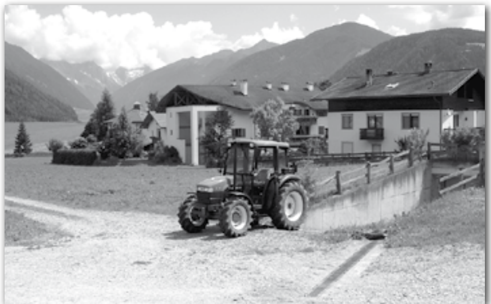
) Die bestehende Auffahrtsrampe des Lagerraumes; in Bildmitte die Fläche für die neue Bauzone, links im Bild der heutige öffentliche Feldweg, der die Zufahrt der Wohnbauzone werden soll. (Foto: „SQ“/rb)
