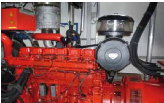
Verbrennungsmotor eines BHKWs
