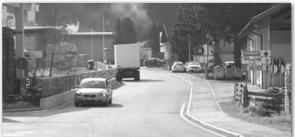
) Die Zufahrtsstraße zur Industriezone musste neu asphaltiert werden. (Foto: „SQ“/rb)
