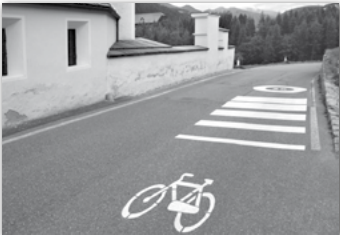
) Die Kurve am Oberolanger Friedhof stellt bisher eine der Hauptgefahrenquellen für Radfahrer dar, daher soll hier die einzige Verbreiterung der Straße zwischen Goste und Oberolang errichtet werden.
