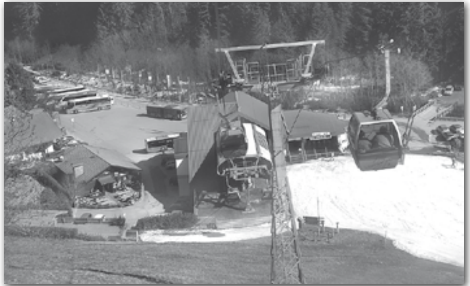
) Für die Infrastrukturen an der Talstation im Gassl stehen Erneuerungen und Erweiterungen an. (Foto: „SQ“/rb)
