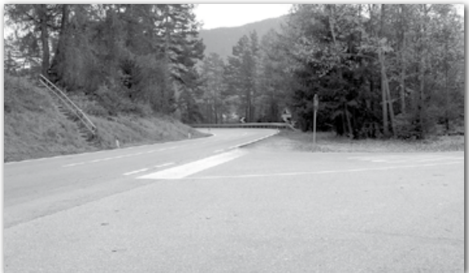
) Die heutige Situation: Wer von Welsberg kommend nach Oberolang einbiegen will, muss oft an der gefährliche Stelle hinter der Kurve anhalten. (Foto: Ing. Zelger / Repro „SQ“)
