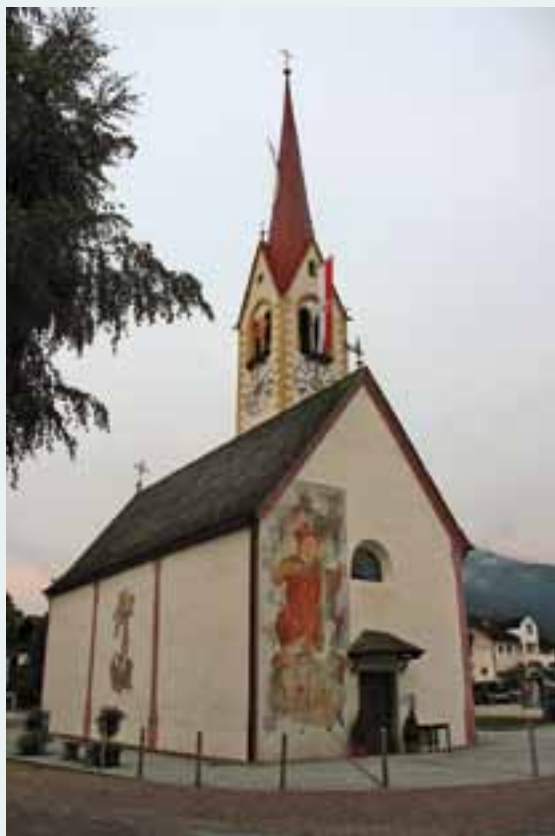
Der Turm der Mitterrolanger Kirche erhielt im Zuge der Sanierung zwei neue Kirchenglocken
