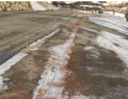
Bis zur Häusergruppe Mitterhofer sind die Leerrohre für die Glasfaserleitungen verlegt worden
