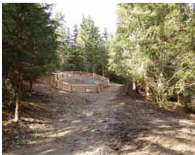
Die Neufassung der Oberegger Quellen bringt eine beachtliche Steigerung der Schüttung
