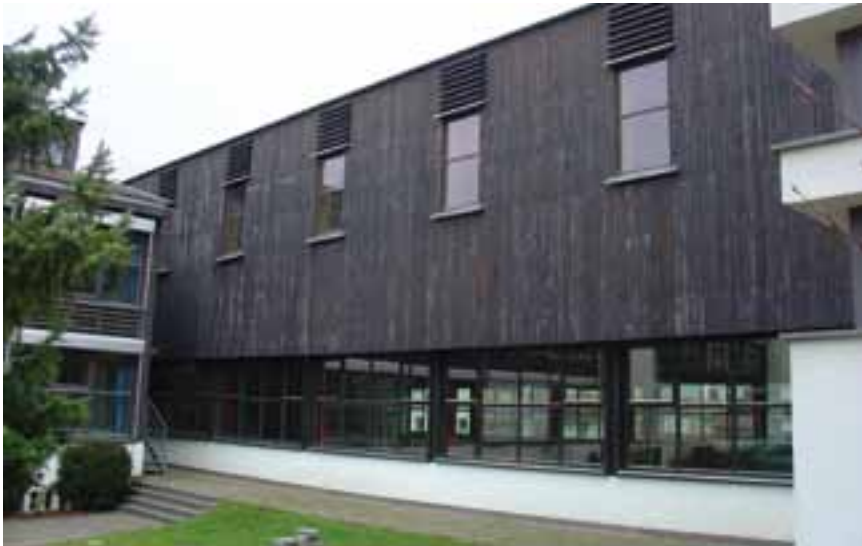
Die Erweiterung der Umkleibereiche und des Geräteraumes erfolgt unterirdisch auf einem Teil des Pausenhofes
