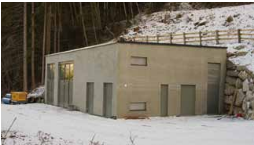
In Kürze wird das E-Werk Furkelbach ans Netz gehen
