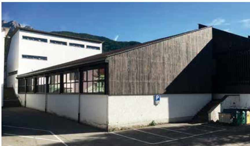
Die Firma Pronorm Consulting GmbH aus Bozen übernimmt im Auftrag der Gemeinde Olang die Ausschreibung der Planungsarbeiten für die Sanierung der Turnhalle und den Einbau eines Aufzuges bei der Mittelschule in Mitterolang. Die Kosten hierfür betragen 9.500 Euro.
