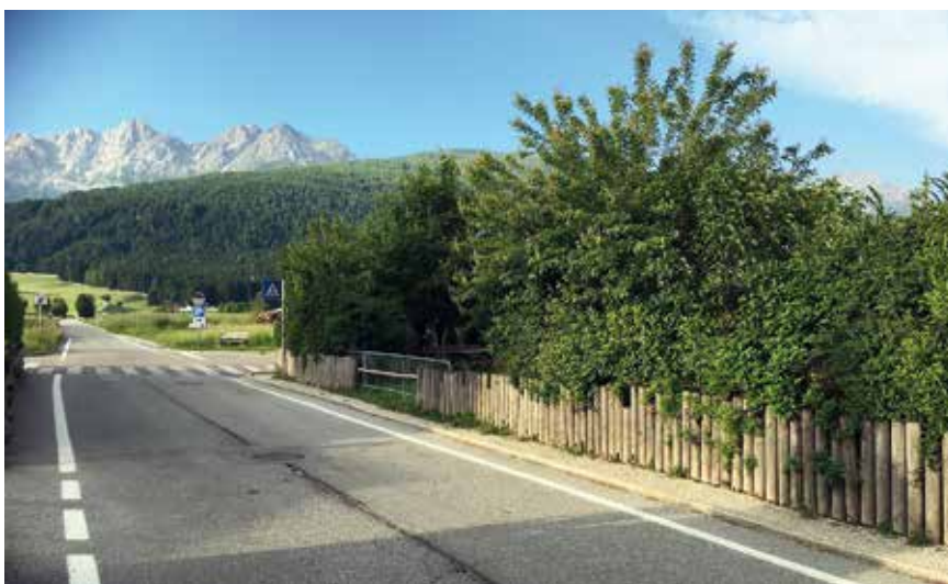
Die Fa. Plaickner Bau hat den Zuschlag für die Verbreiterung des Gehsteiges und die Errichtung einer Holzumzäunung erhalten. Die Baukosten betragen 29.246,09 Euro.
