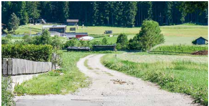
Der Steinwallweg wird asphaltiert, damit er von Rollstuhlfahrern benutzt werden kann.
