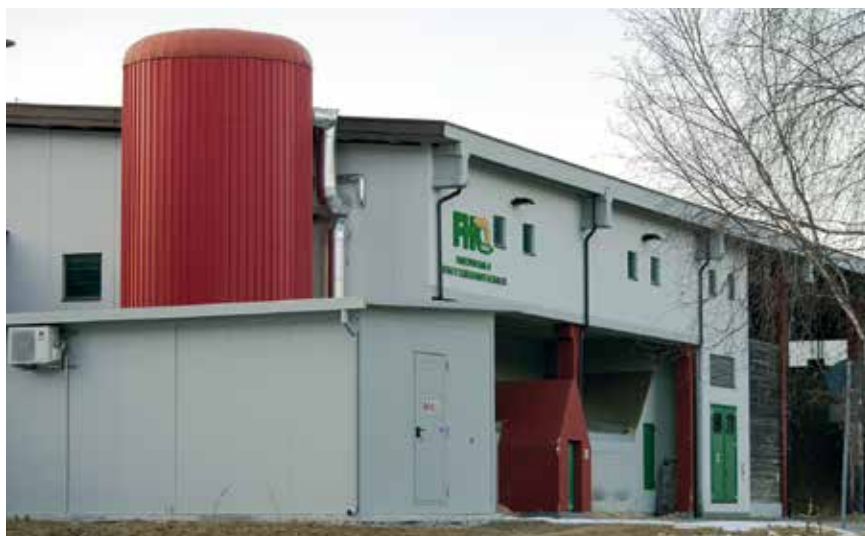
Durch die Zusammenarbeit zwischen Gemeinde und Fernheizwerk bei der Verlegung des Breitbandinternets in Olang kann einiges an Zeit und Geld eingespart werden.
