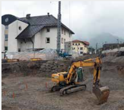
Später als geplant wurden mit den Abbrucharbeiten am Kindergarten Niederolang begonnen. Mittlerweile aber ist der Aushub abgeschlossen und die eigentlich Bauarbeiten haben begonnen.
