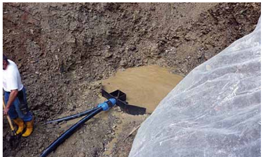
Neuer Flügelschacht mit Ableitungsrohren.
