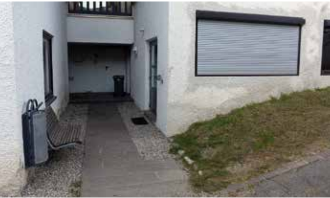
Der Jugendtreff im Gebäude der Mittelschule ist wieder geöffnet.
