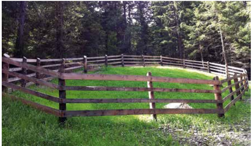
Eine fertiggestellte und eingezäunte Quellfassung.
