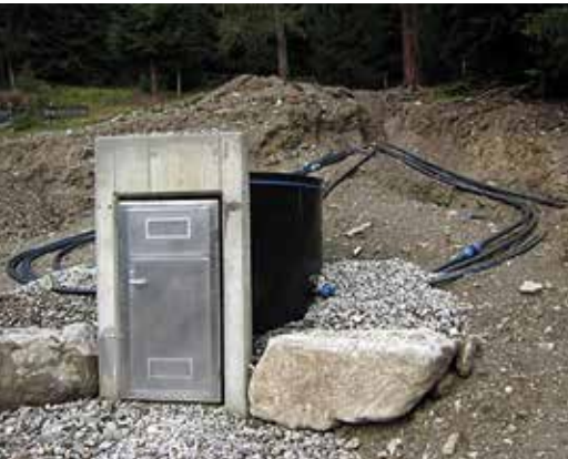
Sammelschacht – während dem Einbau.
