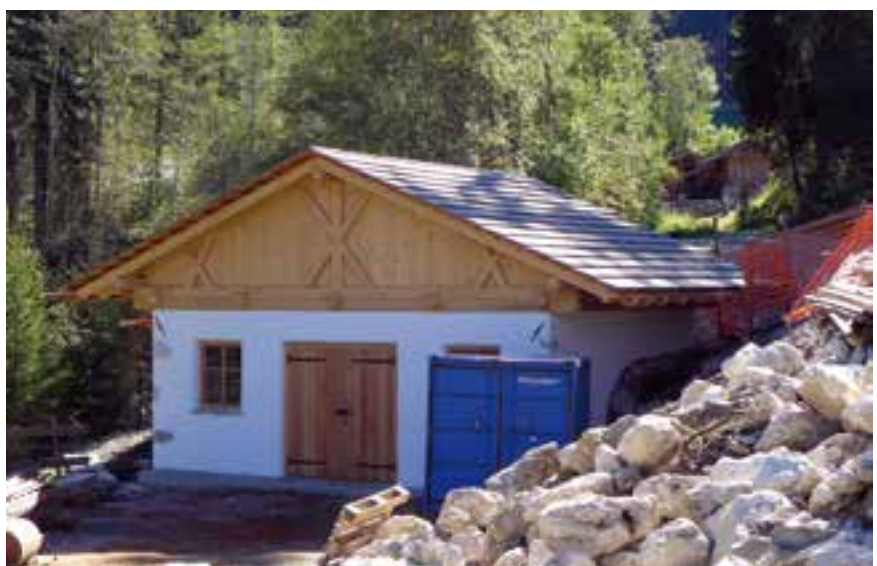
Die Bauarbeiten für die Hammerschmiede sind mittlerweile größtenteils abgeschlossen.
