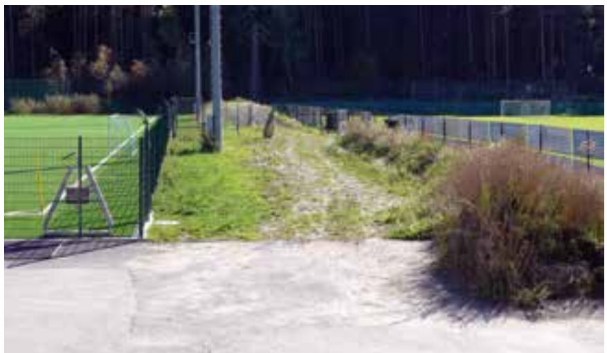
Die Garage und die Dammschüttung werden zwischen Kunstrasenplatz und Fußballplatz errichtet.
