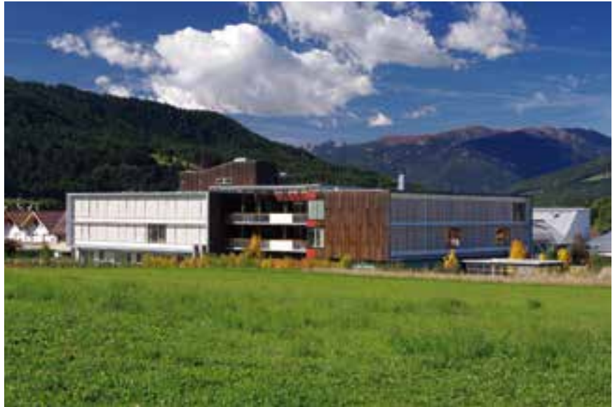
Auf dem Dach des Pflegeheims wird eine Photovoltaikanlage installiert.
